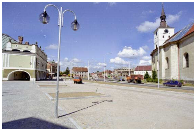
JV kvadrant - stav po rekonstrukci
