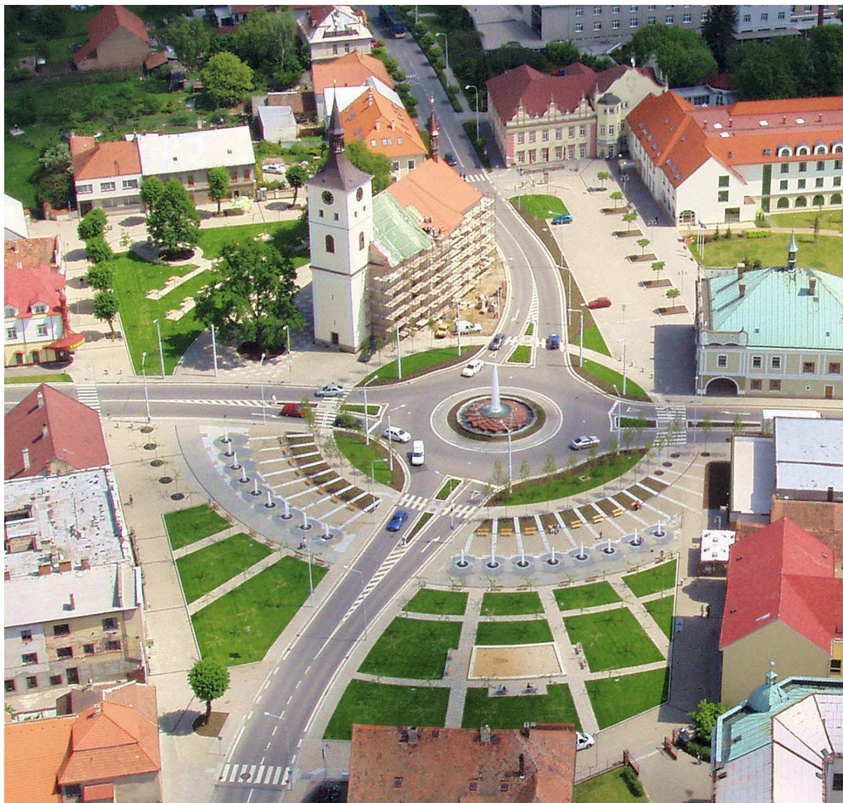
Letecký pohled na rekonstruované náměstí
